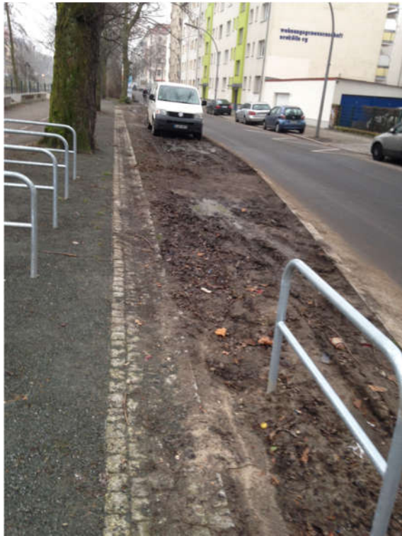
Bauteil A in Richtung Wildenbruchstraße Stand: 22.01.2018
